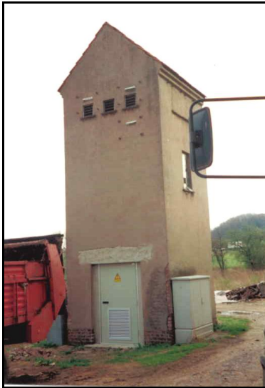
Trafostation Uder „Ziegelei“ (1999) „B80“
